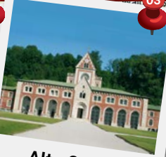
Alte Saline Bad Reichenhall
